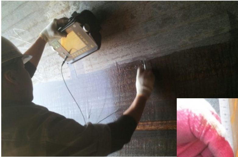
UT check of longitudinal weld
